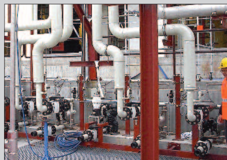
2" Doppelmembranpumpen zusammen mit PVDF Pulsationsdämpfern in einer Anlage eingebaut für die Beladung von Fluorwasserstoffsäure.
