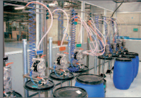
1/2" Doppelmembranpumpen installiert in einer Farbförderanlage.
