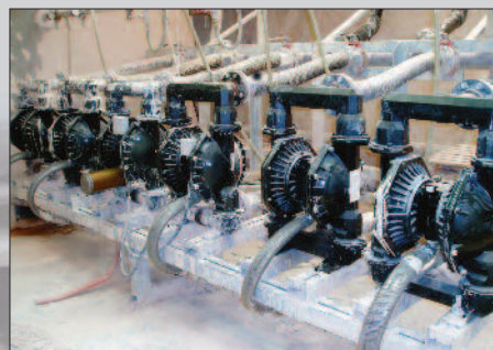
3" Membranpumpe eingesetzt zur Förderung von Schlacker in einer Keramikproduktion.
