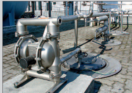
1 1/2" Doppelmembranpumpe installiert in einem Betrieb zur Förderung von Chemikalien (Chlorid-Methylen Verbindungen).
