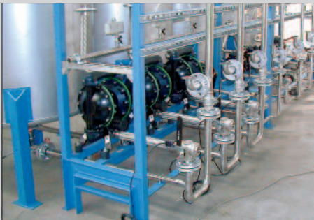
1 1/2" Aluminium Doppelmembranpumpen installiert zur Befüllung eines chemischen Reaktors.
