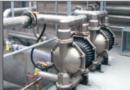
3" Edelstahl Doppelmembranpumpe installiert in einem Prozeß bei dem große Fördermengen benötigt werden.
