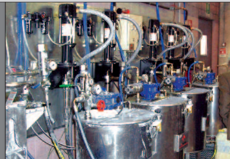
2-Kugel-Ventil- Kolbenpumpe, 11:1 übersetzt, eingesetzt zur Farbzirkulation.
