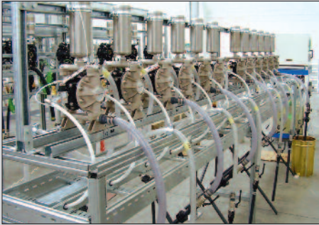
1/2" Doppelmembranpumpen installiert in einem System zur Druckfarbenherstellung.
