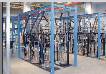
Große Extrusions Kolbenpumpen, 13:1 übersetzt, installiert in einem System zur Offset Anwendung.
