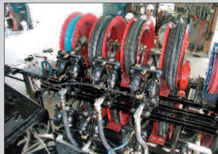
1" UL zertifizierte Kraftstoffpumpen installiert zur Kerosinbefüllung.
